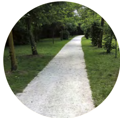
pavimentazione drenante in calcestre
