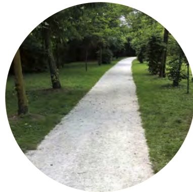
pavimentazione drenante in calcestre
