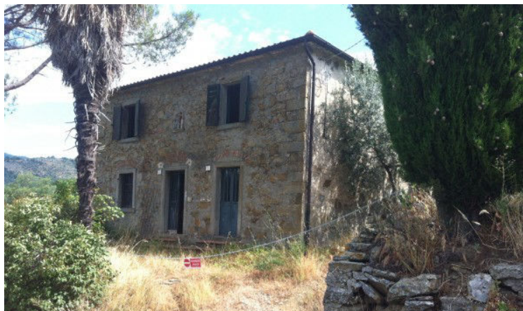
Comune di Castiglion Fiorentino – Casa colonica da ristrutturare
