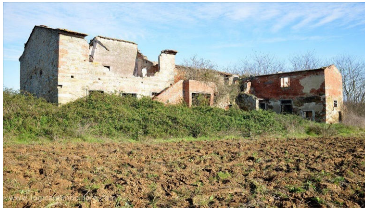
Comune di Cortona – Casale da ristrutturare
